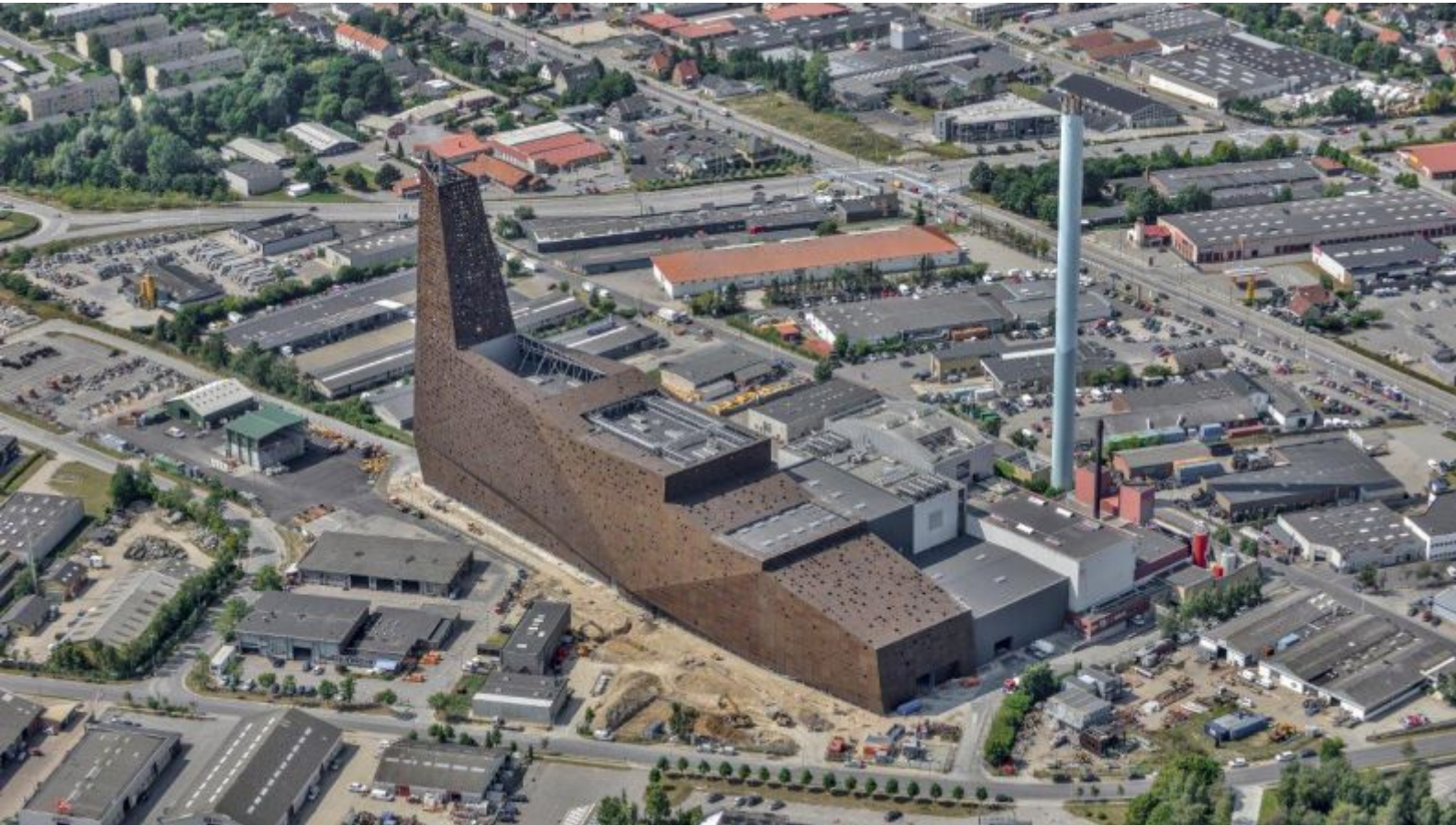
WtE plant in Roskilde, Denmark, with kind permission of MARTIN GmbH für Umwelt- und Energietechnik
